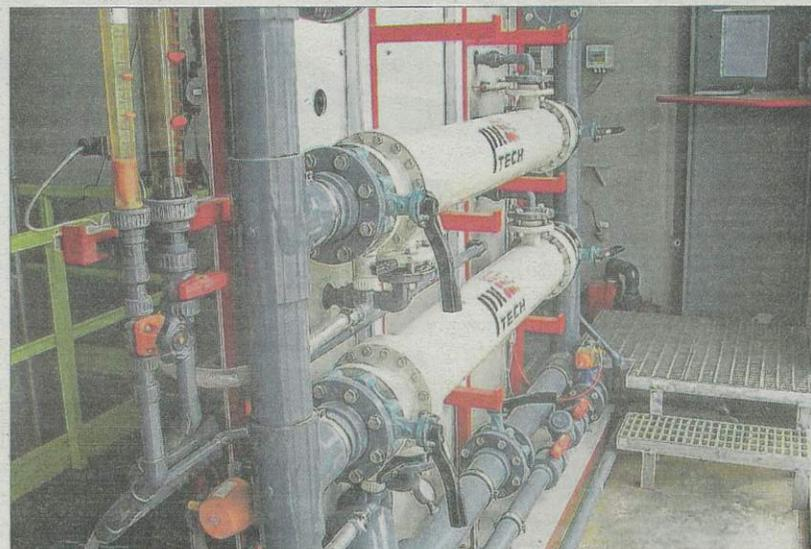
Chez Precirex, un circuit de filtration permet d'arriver au traitement de 100 % des eaux des process avant le rejet dans le réseau communal.
